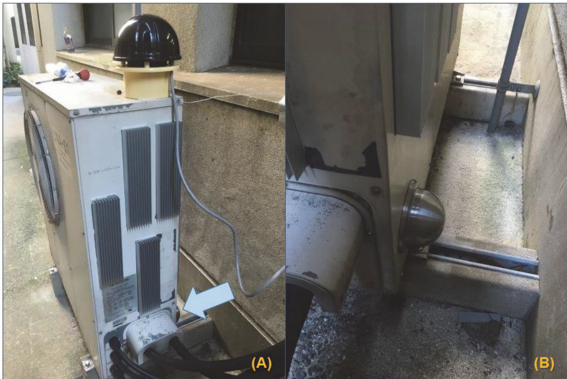
図3 (A) 室外機の熱交換部分（ヘリウム \leftrightarrow 油）の上下に穴を開け、上部（図1のYに対応）にファンを取り付けた。(B) 下部吸気口（図1のXに対応）にはアルミ製パイプフードを設置している。なお、側面のアルミ製放熱フィンも熱交換部分の冷却をするために取り付けたものであるが、ほとんど効果がなかった。
